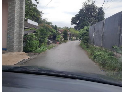
Gambar 2. Kondisi Jalan Desa Cigaru
